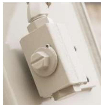
Rubinetti apri/chiedi all'uscita dell'impianto ausiliario per evitare spillamenti e perdite di pressione in fase di installazione/ disinstallazione attrezzature.
