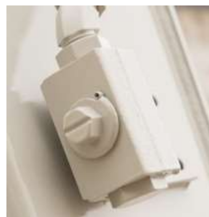
Rubinetti aperti/chiusi all'uscita dell'impianto ausiliario per evitare spillamenti e perdite di pressione in fase di installazione/ disinstallazione attrezzature.
